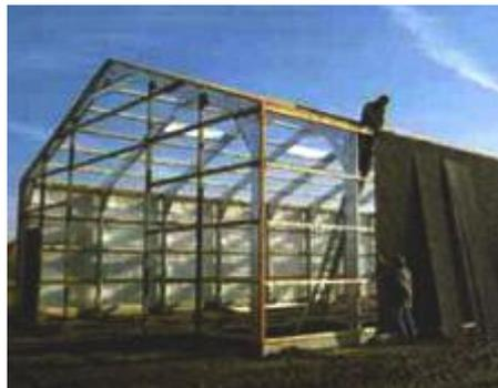
foto 0.41. Colocación de fachada sobre nave industrial.
