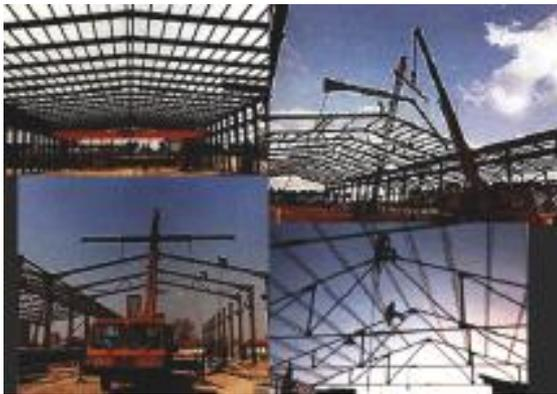
foto 0.36. Montaje de nave metálica.
